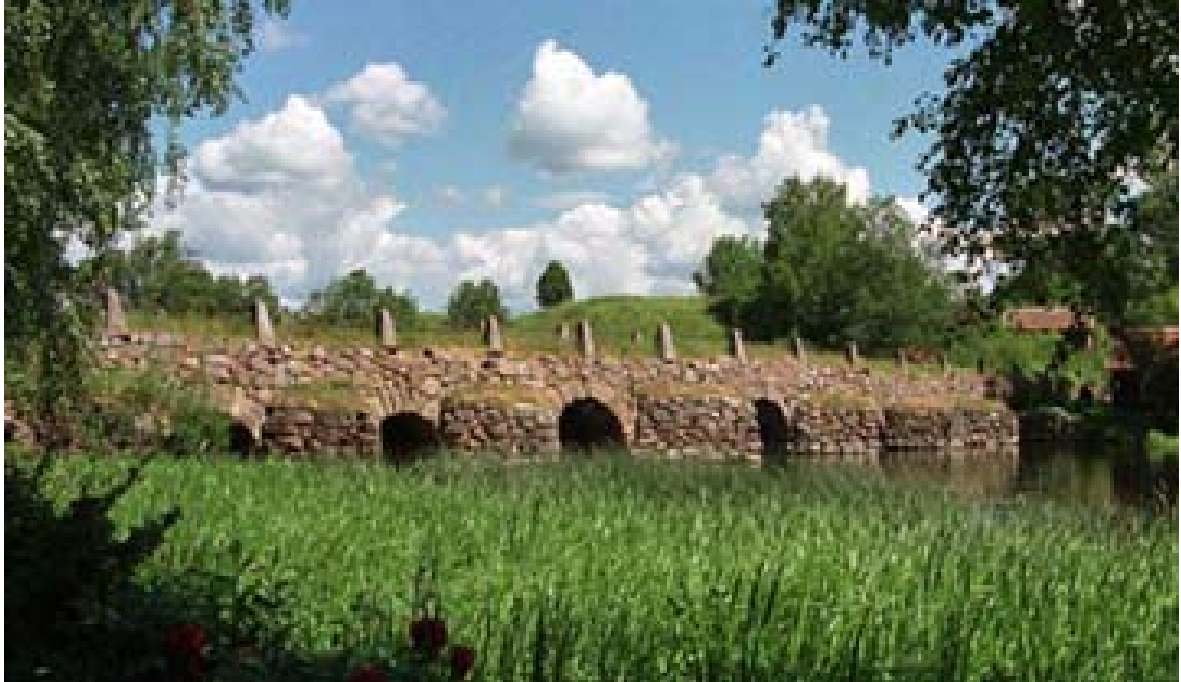
Den bevarade gamla bron byggdes tvåhundra år efter Olof Nilssons tid.
